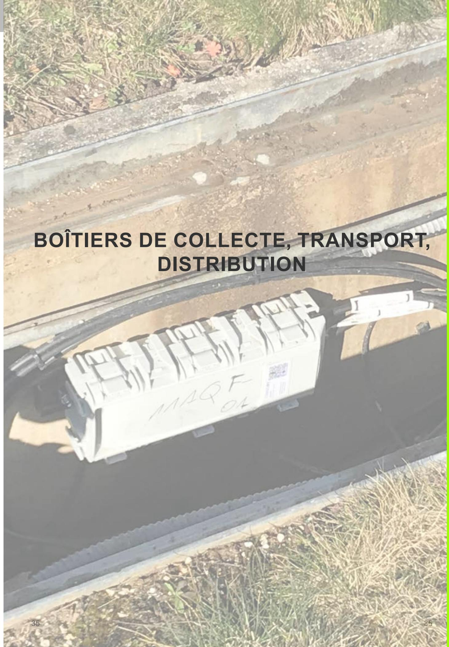
Le BPEO Taille 0 a été spécialement conçu pour le branchement d'abonnés sur le réseau de distribution FTTH. Son format compact permet de l'installer dans tous types de chambres souterraines y compris les plus petites.
